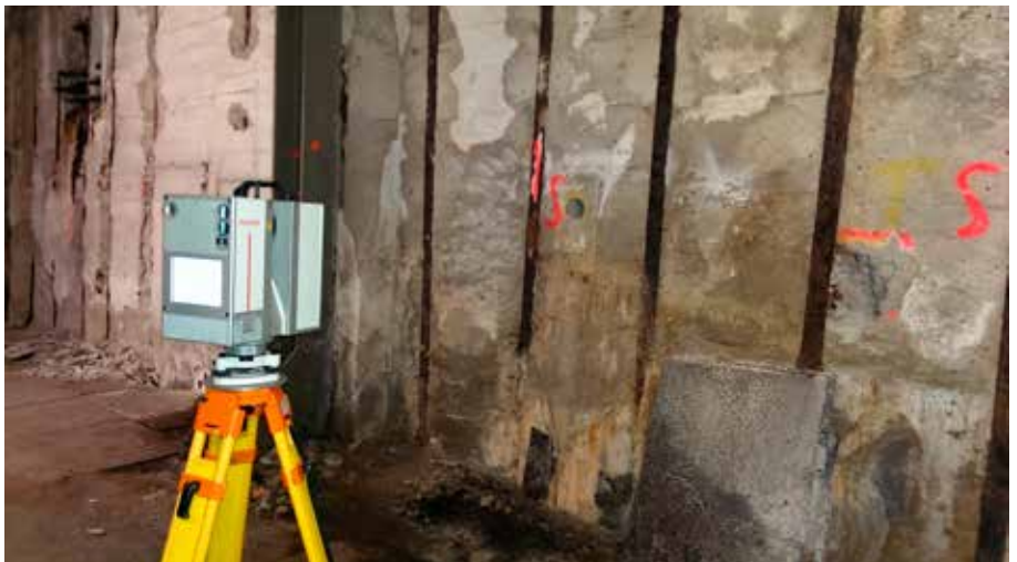
Vermessung der Giebelwand in südlicher Richtung zum Oranienplatz. Foto: Laserscan Berlin
